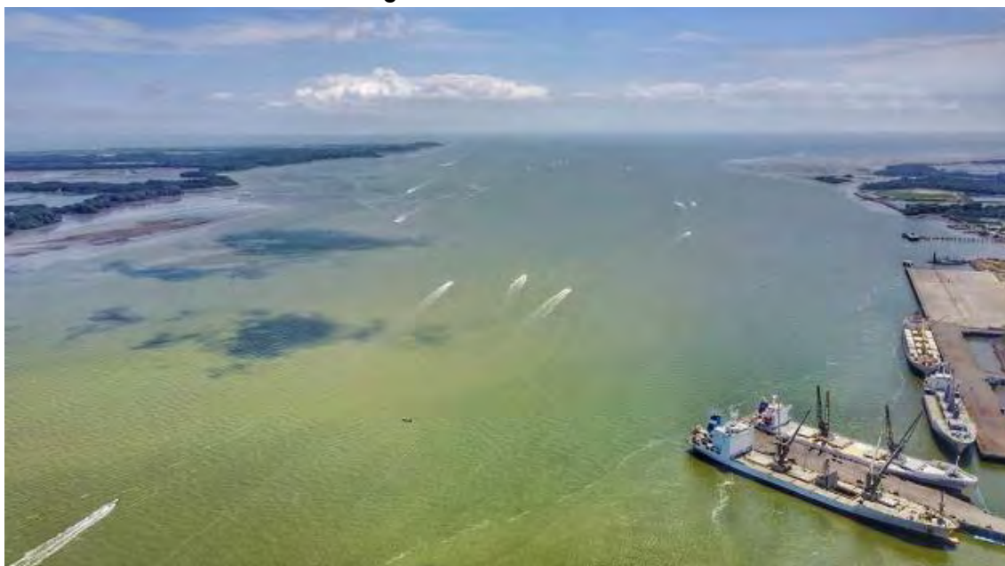
Fotografía V-3: Canal de acceso
