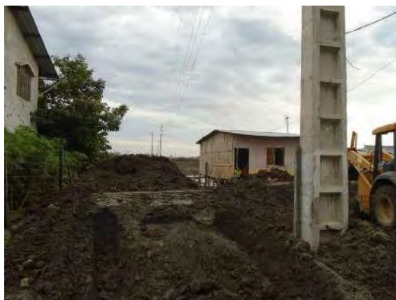
MATERIAL DE RELLENO A ASENTAMIENTO VIRGEN DEL CISNE
